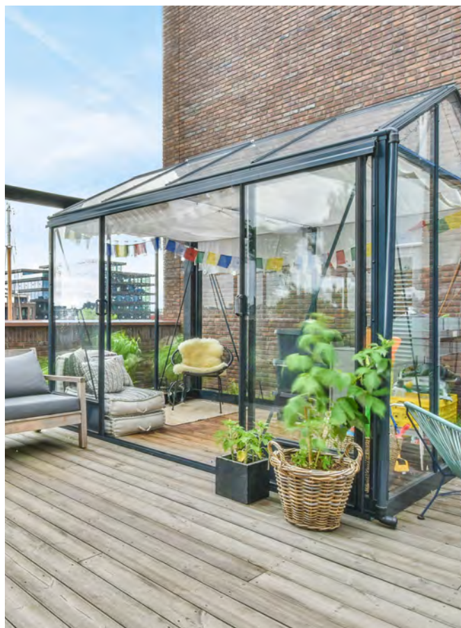
MWPC används i växthus på grund av materialets låga vikt, slagtålighet, robusthet samt UV-resistens.
