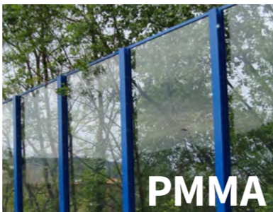
PMMA (polymetylmetakrylat) används främst till utomhusapplikationer och butiksinredningar.
